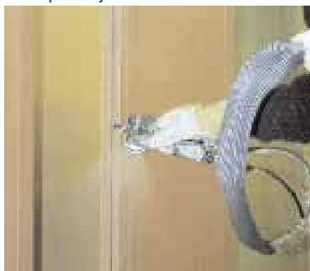
8 Nanošenje završnog premaza špricanjem
