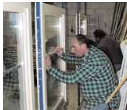
9 Montaža gotovih prozora
